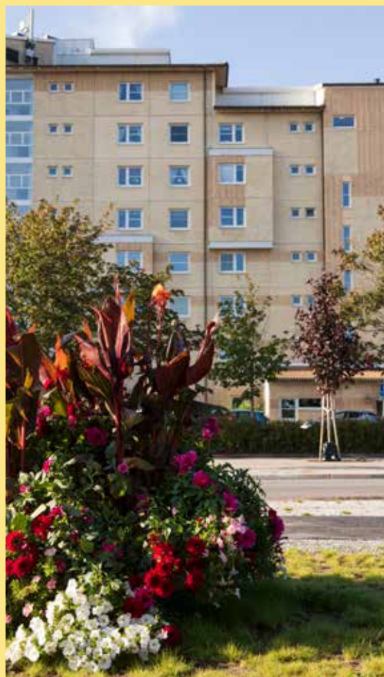
I Barkarby C har ny teknik gjort det möjligt att fördubbla återvinningen av värmen i den använda luften.
