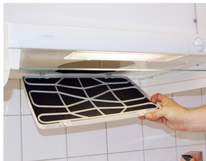
Ta loss filtret. Torka rent bakom filtret, upp i fläkttrumman.
