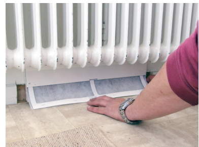
3. Sätt in det rena filtret. Det ska ligga innanför nedre plåtkan-
